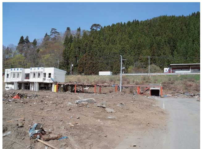
写真1 三陸鉄道被災状況 （被災1か月後の田老駅前 2011年5月 武田撮影）
